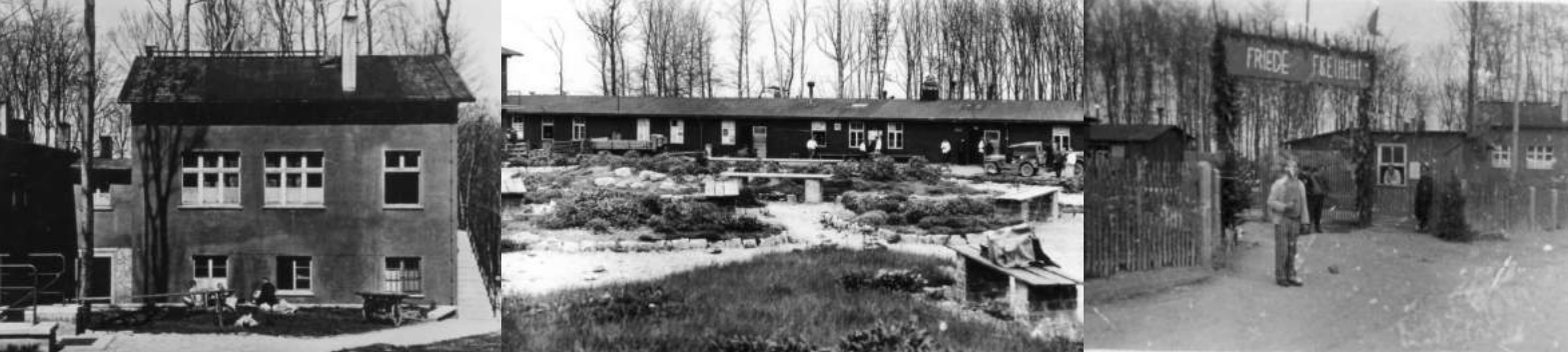
OP-Bau 2, Krankenbaracke und Eingang zum Krankenlager nach der Befreiung Quelle:buchenwald.de
